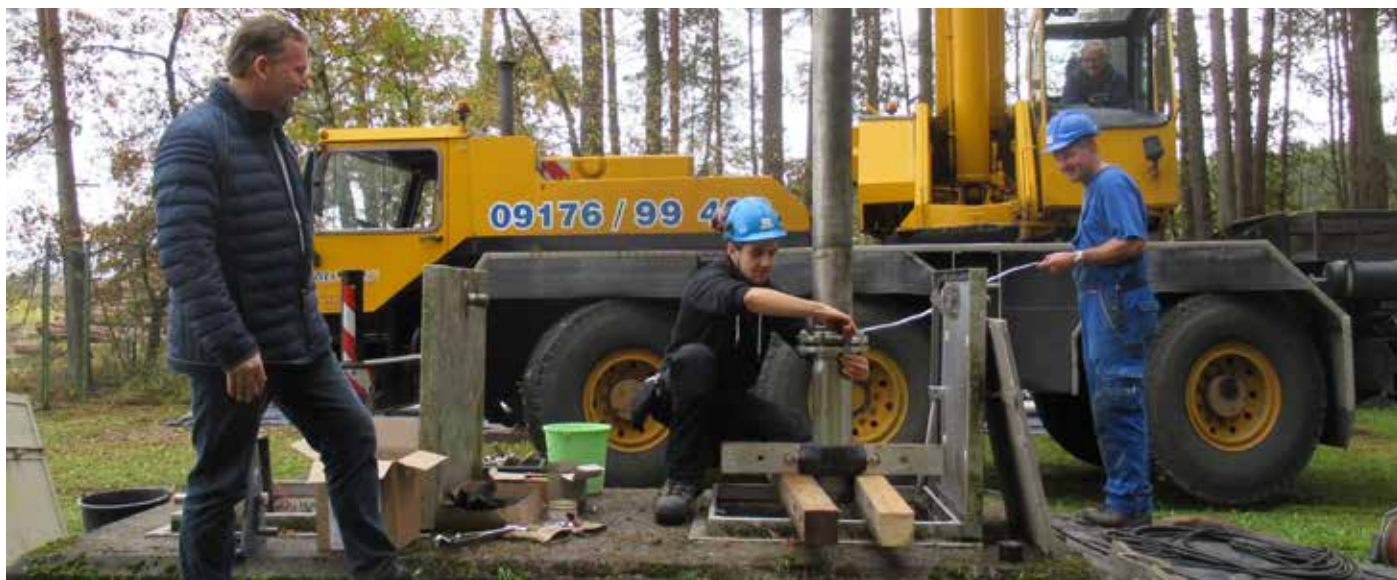
Oben: Eine Spezialfirma prüft unter den Augen von Thomas Schneider Teile der Brunnenanlage.
