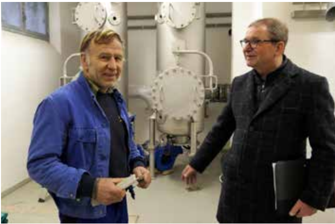
Abb.3: Wasserwart Norbert Mederer erklärt Dr. Klaus-Jürgen Klement von der Redaktion der geplanten ‚Gemeindechronik Röttenbach‘ seinen Aufgabenbereich im Wasserhaus am Hirtenbuck.
